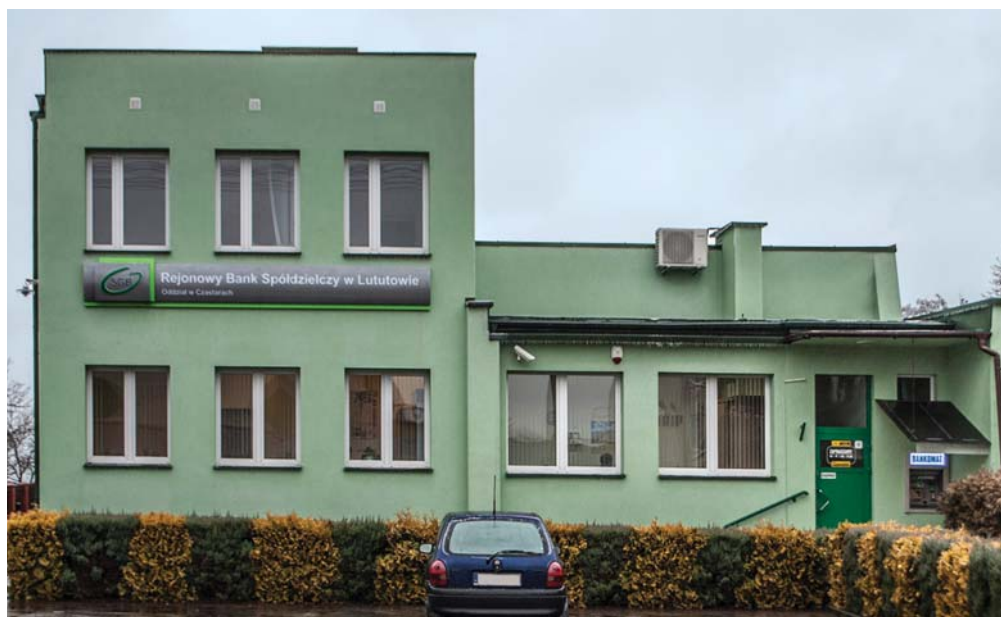
Siedziba Oddziału w Czastarach po modernizacji
