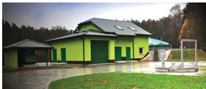
Oczyszczalnia ścieków. Fot. ze strony internetowej gminy Brąszewice
