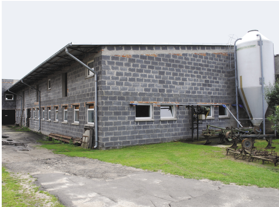
Nowa chlewnia zapewnia dobre warunki do prowadzenia hodowli
