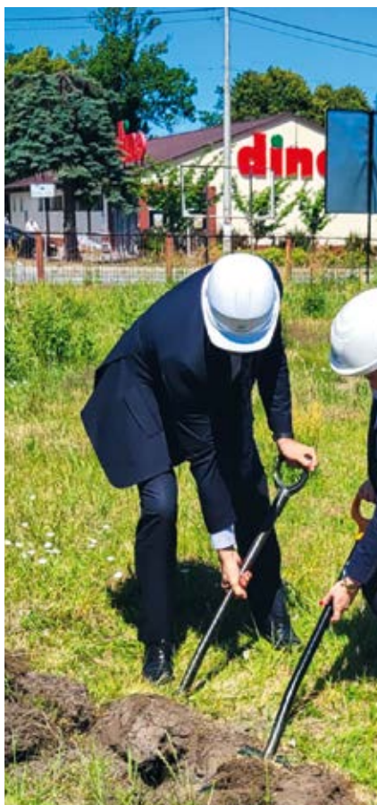
Przedstawiciele Banku wspólnie z Inspektorem Nadzoru Budowlanego rozpoczynają budowę
